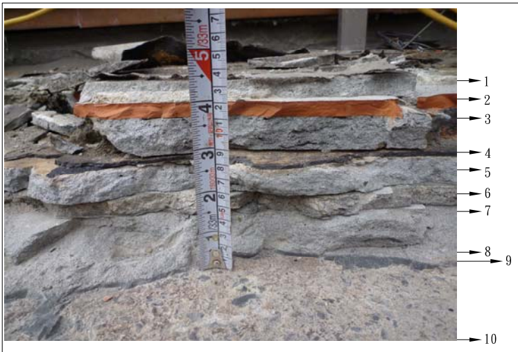
圖 3-8 監察院屋頂平台歷代防水層拆解後斷面現況
